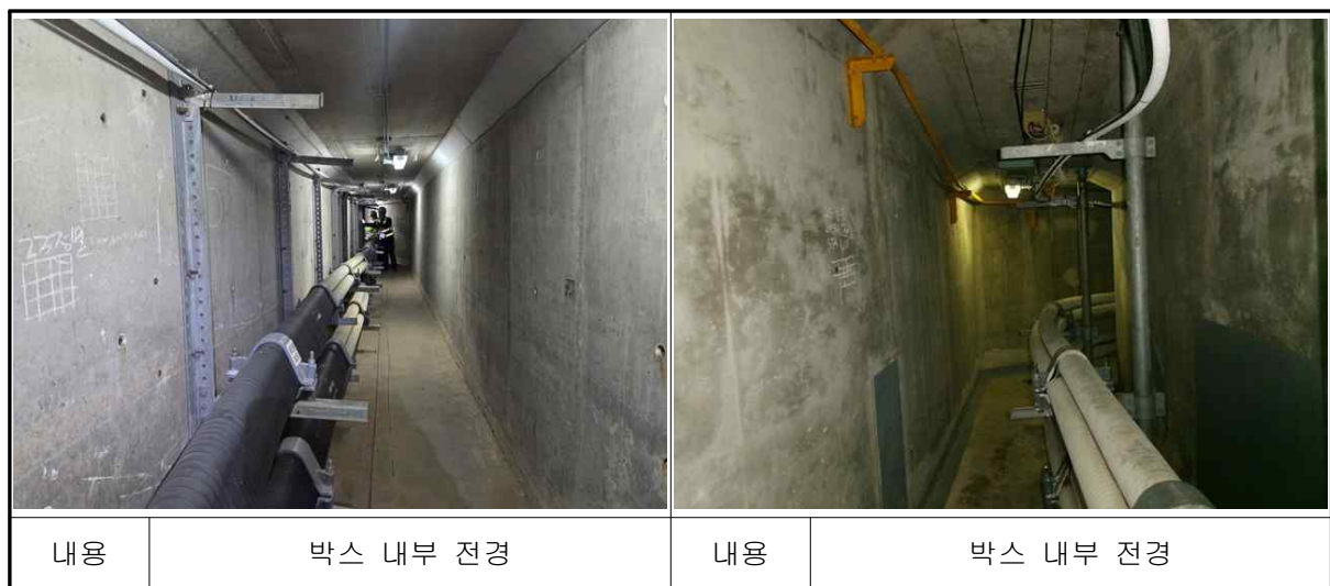
【사진 4.1】 송포일산인출 전력구 현황
